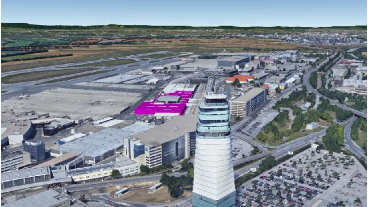
Abbildung 19 Tower in Richtung der Solaranlage
